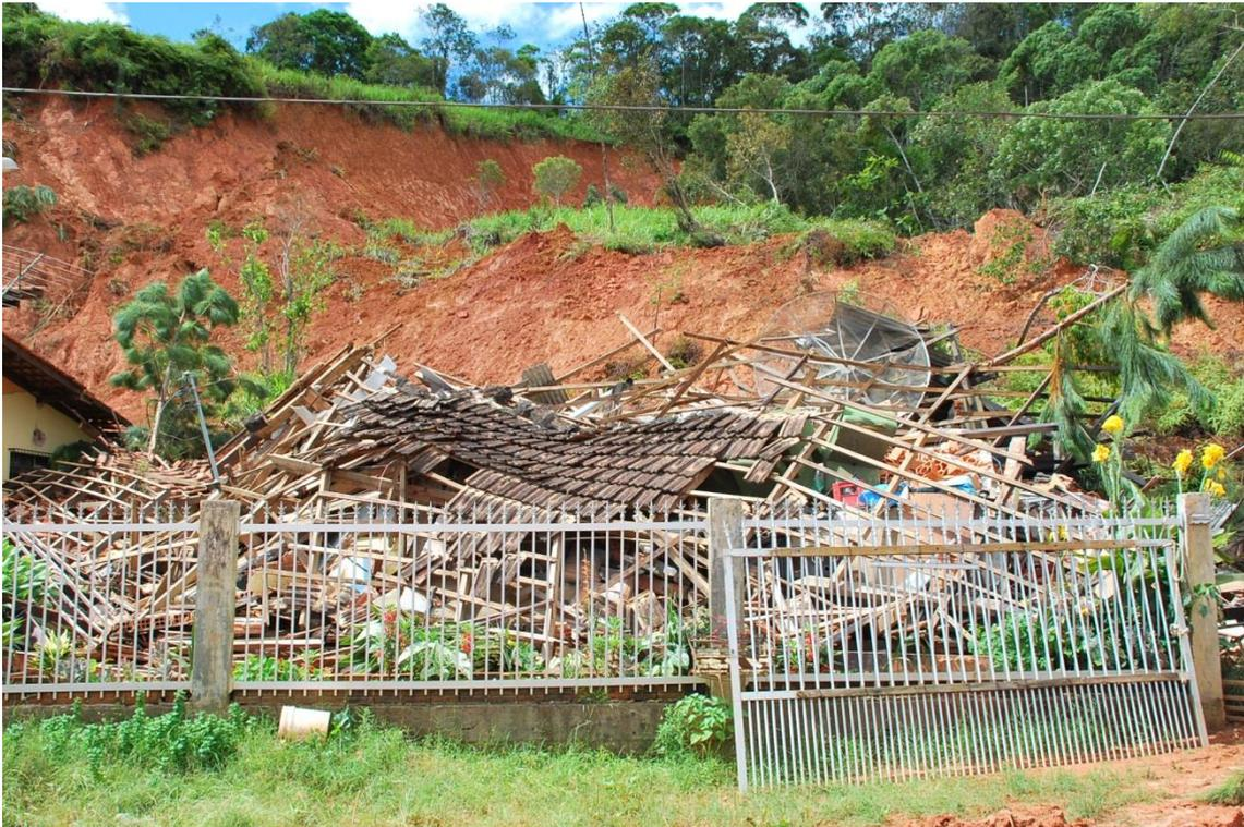
**Foto 1 – Mostra a alta vulnerabilidade física da edificação após movimento de massa na área de risco do Bairro Fortaleza Alta, Blumenau/SC. Fonte: Defesa Civil de Blumenau/SC, 2017.**
